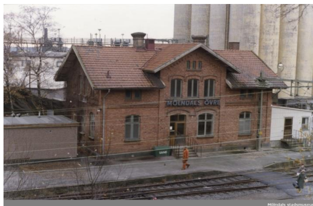
Här har ställverket bytts till ett modernare
